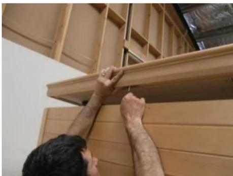
11. Assicurarsi che ognuno dei cavi conduttori sulla parte superiore del pannello sinistro, destro, posteriore e anteriore sporgano attraverso il pannello superiore; quindi collegare ciascuno dei 5 cavi conduttori nei 5 connettori del pannello superiore.
