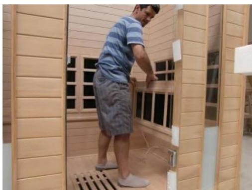
7. Far scorrere in basso il pannello di supporto posteriore per la panca verso i supporti di legno con il radiatore per i polpacci rivolto verso l'esterno. Assicurarsi che le due fessure laterali del pannello di supporto per la panca scorrano completamente nelle corrispondenti scanalature dei supporti in legno.
